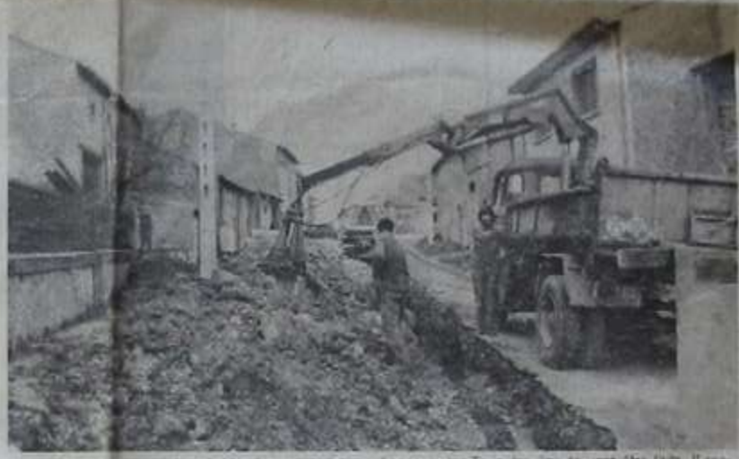
La première tranche d'assainissement est en bonne voie. Tous les égouts vont être faits. Il restera ensuite l'évacuation des eaux et les trottoirs dans le village.
